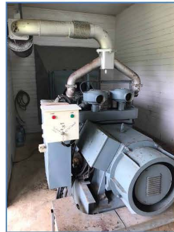
ภาพถ่ายที่ 2.2-15 เครื่องกำเนิดไฟฟ้าสำรอง
