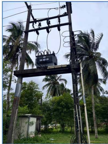
ภาพถ่ายที่ 2.2-14 หม้อแปลงไฟฟ้าของโรงแรม
